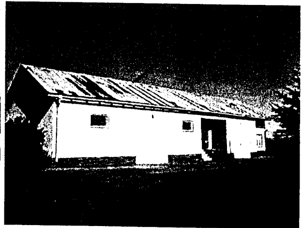
sklad chemikálii s.č.309 (p.č.2826/20)
