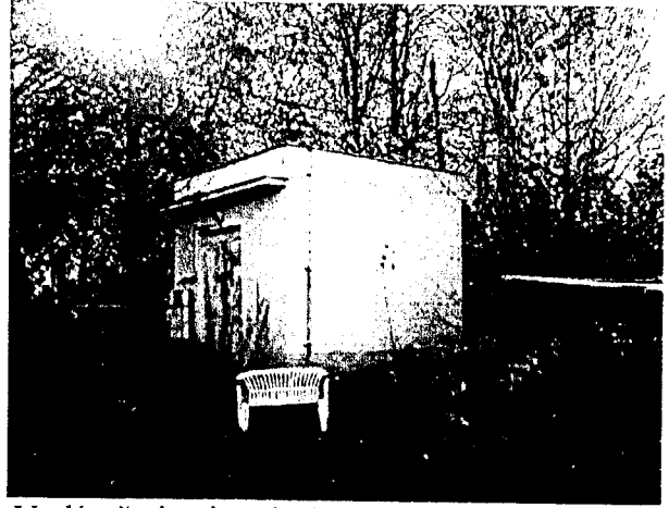
Vodáreň pitnej vody (p.č.2826/22)
