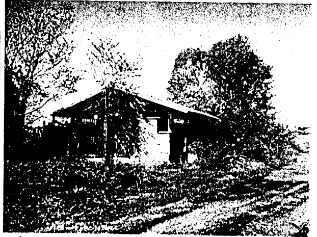
drevený prístrešok pri garážach - SKLAD PHM s.č. 362 (p.č. 2826/27)
