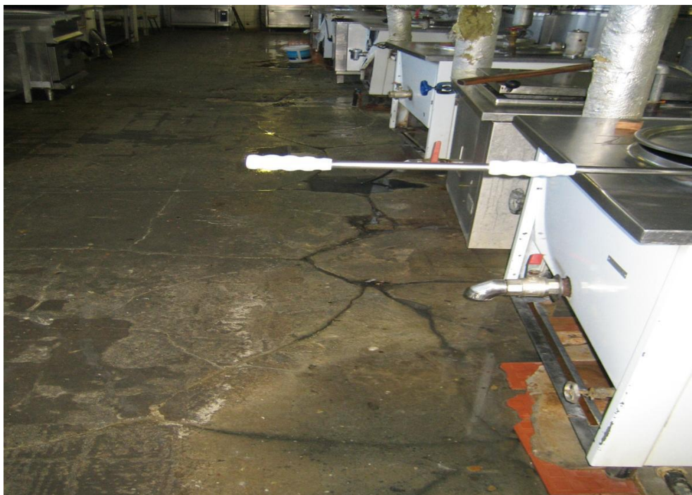
Vývarovňa pre odsúdených - kapacita na 1 zvarenie je 1430 porcií - denná príprava troch hlavných jedál – denne 4290 porcií hlavných jedál plus príprava desiaty a olovrantu pre pracujúcich odsúdených
