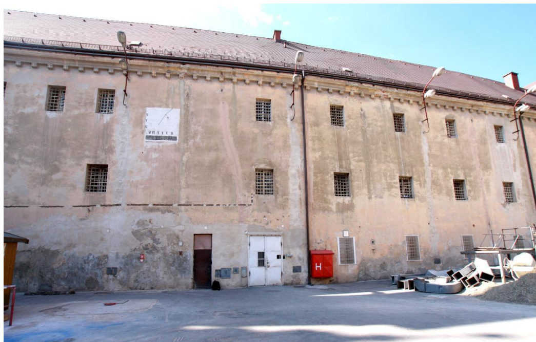
Objekt č. 6 - pohľad z dielenského dvora na ubytovaciu časť pre odsúdených – umiestnených 551 osôb
